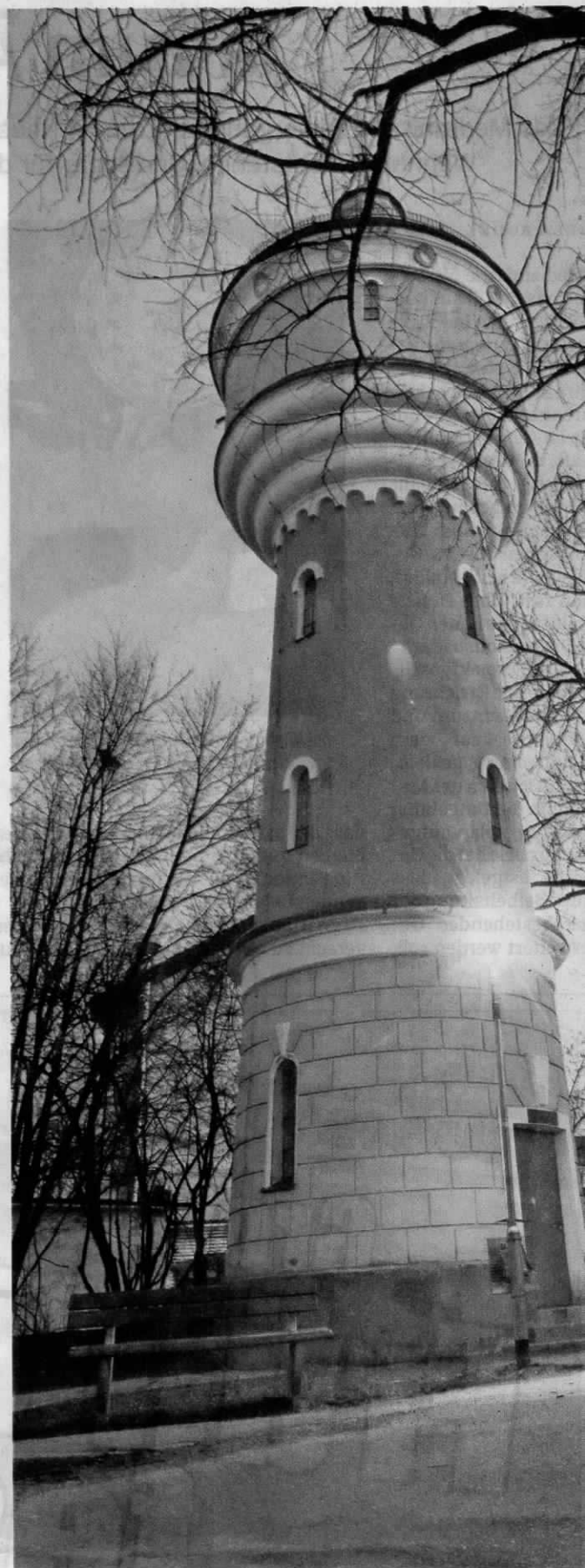
Der schöne Schein trägt: In Oberhaching – hier der alte Wasser- Probleme mit einem erhöhten Nitratgehalt im Trinkwasser. Foto: ...
